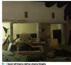
I lavori all'interno dell'ex cinema Empire
