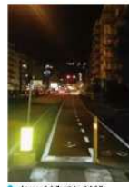
I lavori della pista ciclabile
