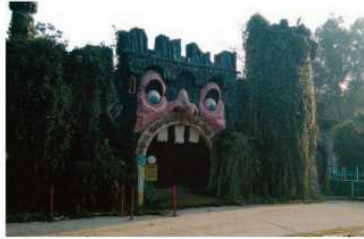
LA RIAPERTURA. Il comune di Napoli ha chiesto alla società New Edenlandia di predisporre un progetto che consenta la parziale riapertura del parco giochi di Fuorigrotta per il 19 giugno 2015. In quella data, infatti, l'Edenlandia compie 50 anni e l'amministrazione mira a poter festeggiare con la cittadinanza il compleanno del parco divertimenti cittadino. A sinistra: la situazione è stata l'assessore ai Lavori pubblici Carmine Piscopo in consiglio comunale a maggio
