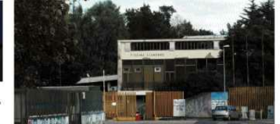
La ristrutturazione della piscina Scandone è in corso. In alto: il progetto di viale Giochi del Mediterraneo
