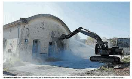
La demolizione. Sono cominciate le opere per la realizzazione della cittadella dello sport alla caserma Boscareliello di Miano. A sinistra: il cantiere. A destra: il cantiere. A sinistra: il cantiere. A destra: il cantiere.
