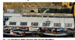
La struttura della piscina del circolo Posillipo
