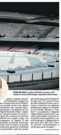
Il nuovo stadio San Paolo in costruzione.
